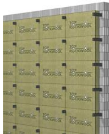
Posa dell'isolante e fissaggio
